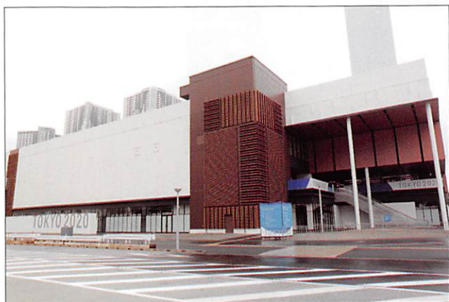
図1 東京2020大会選手村ポリクリニック外観 ©Tokyo2020 この建物の1階部分がポリクリニック。
